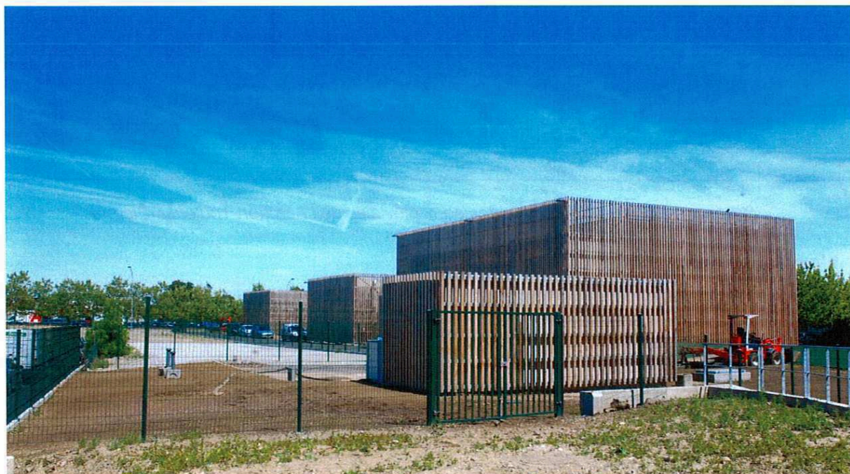
Vue générale de la station - © AEAG
