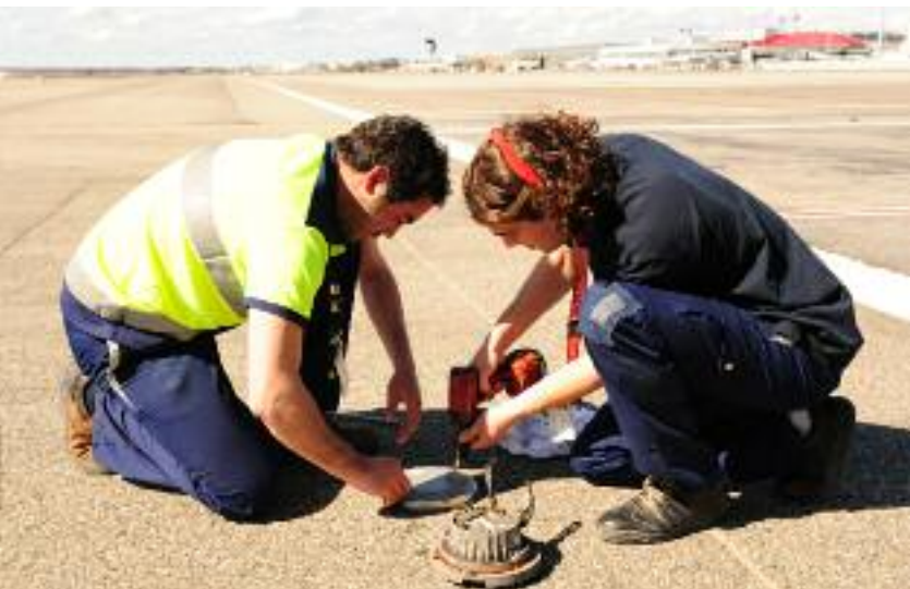
Mise en place des LEDs sur la piste.
