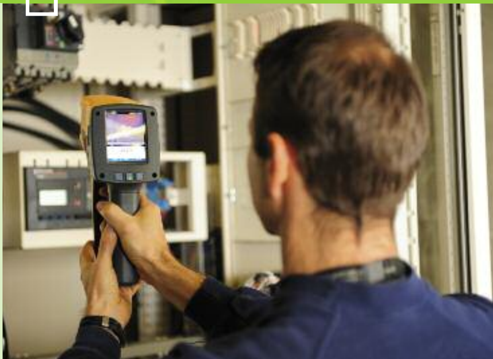
Mesure de la température dans les bâtiments de l'aéroport.
