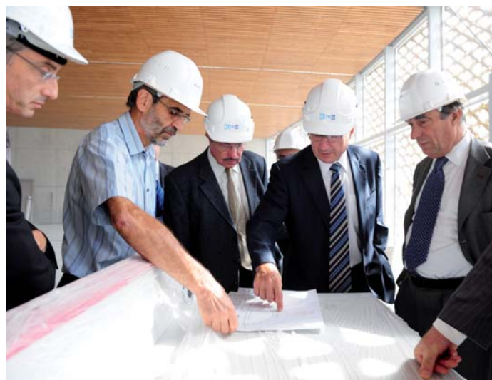
Le Conseil de surveillance en visite sur le chantier du Hall D.
